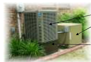
FOTO DE INSTALACIÓN DE MINI CHILLER DE 5 TONS.
